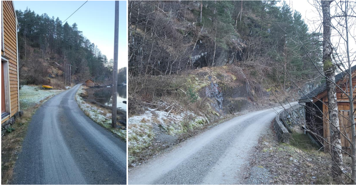
Vegen langs sjø ved brua som er vist over (t.v). Vegen frå der utbetringa vil starte, vegen stig opp frå sjø (t.h.), kjelde: Mowi v/Reidar Våge (nov 2024)
