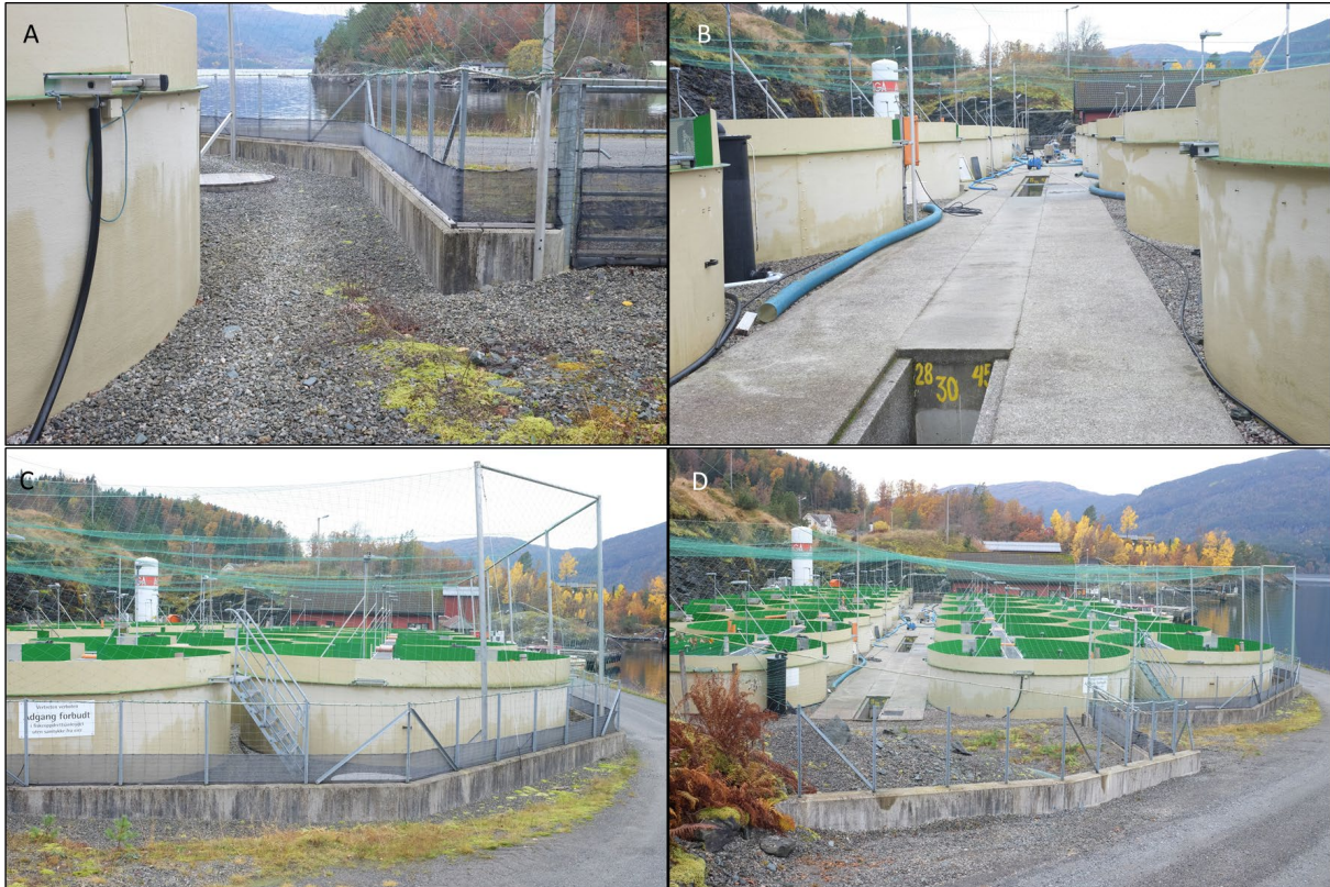
Figur 6 Kar i nedre anlegg; (A) områdesikring med betongmur langs vei. Masser rundt kar består av grov singel. (B) betongdekke og renne for avløp mellom kar. (C) og (D) oversikt over kar og områdesikring.
