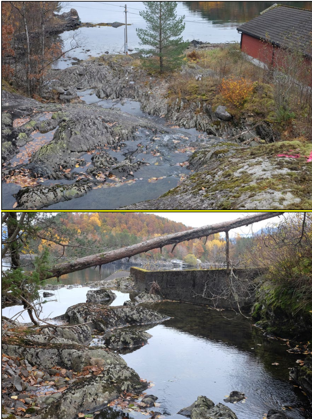
Figur 13 Bilder fra Øyerhamnelva tatt mot nord mot anlegget; Bilde nede viser sikring mot anlegget med betongmur, bilde oppe viser elveløp ved liten vannføring og naturlig elveløp i fjell og naturlig sikring med skrent mot anlegget (Klekkeri)
