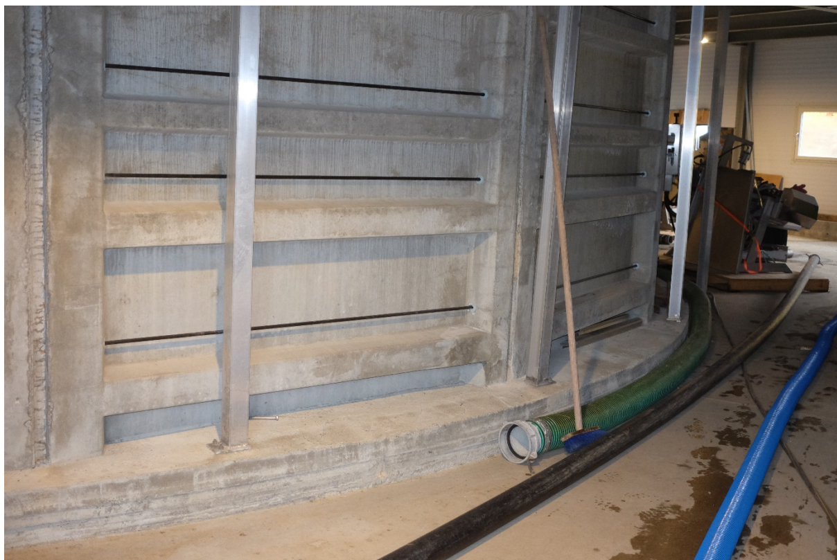
Figur 9 16-meter betongkar i påveksthall
