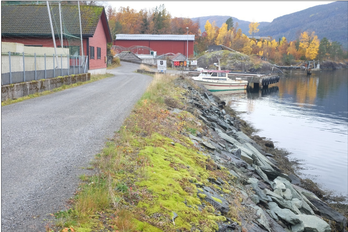
Figur 7 Fylling mots sjø for nedre område
