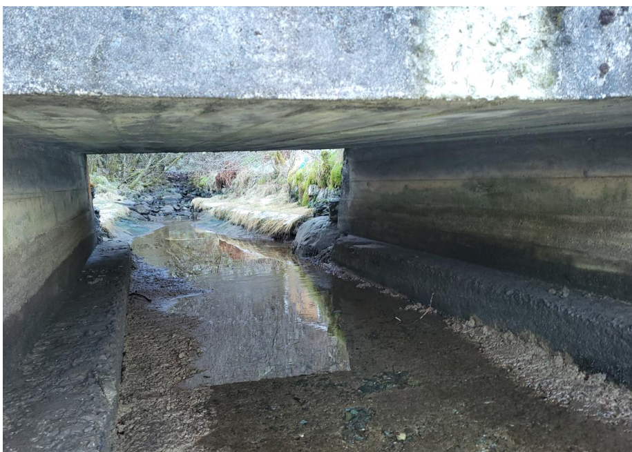
Figur 11 - Bilete av brua etter utbetringa sommaren 2024, kjelde: Reidar Våge (nov 2024)
