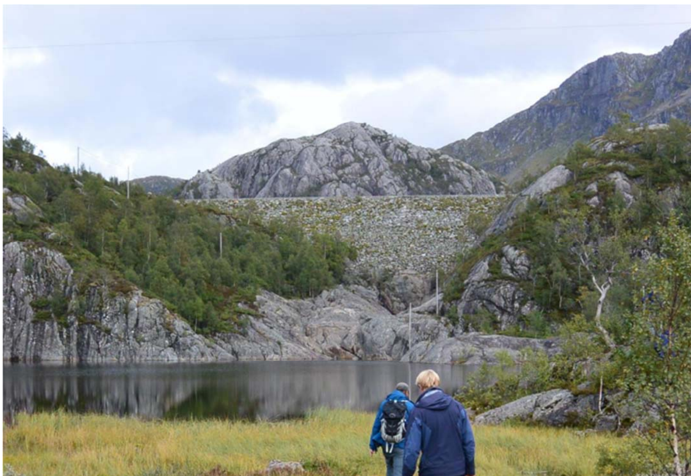
Figur 2 Til venstre på bildet vises skråningen til den nye anleggsveien. Foto: Multiconsult, hentet fra DML.
