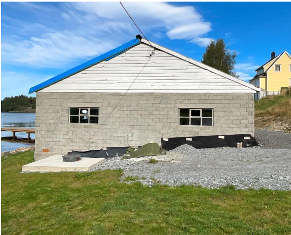
Bilete over eksisterande fasade mot sør
