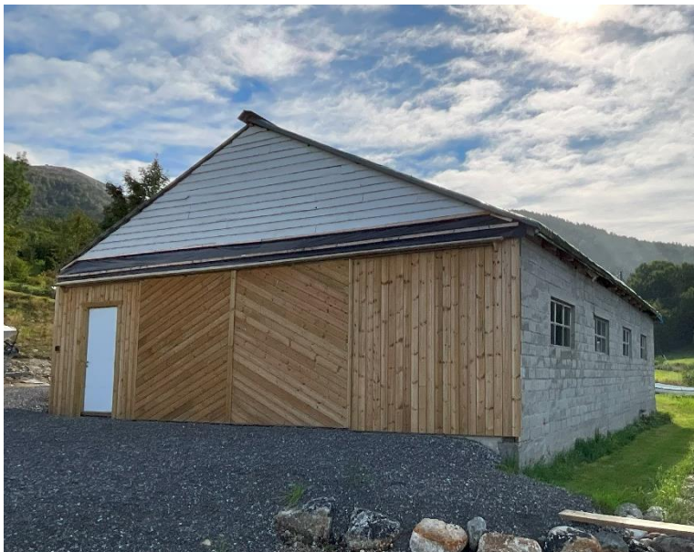
Bilete over eksisterande fasade mot nord.
