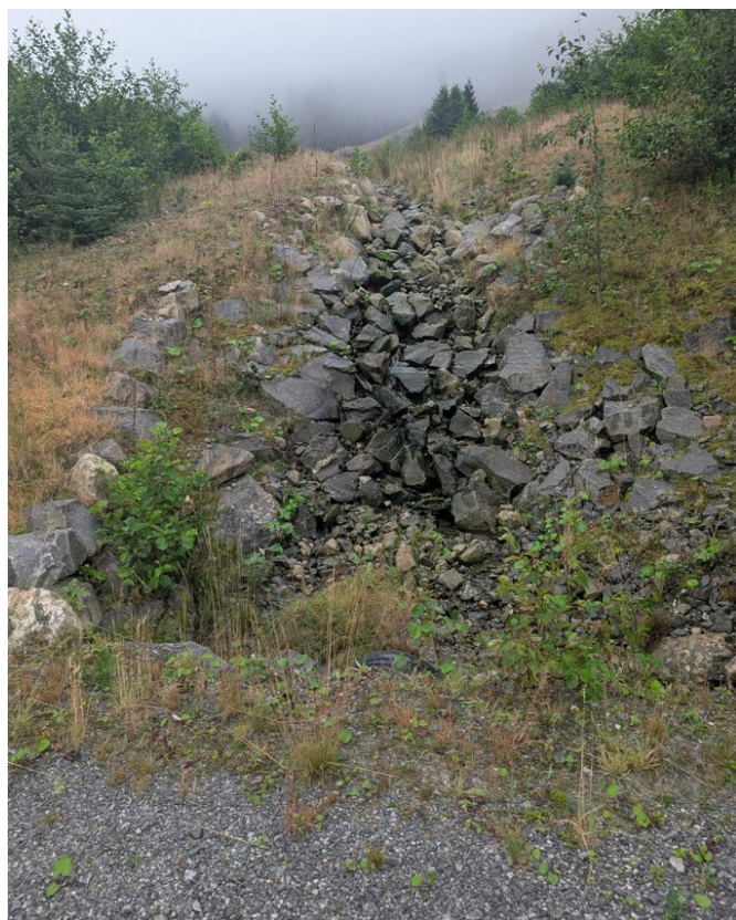
Figur 16. Dreneringsløsninger for overflatevann.
