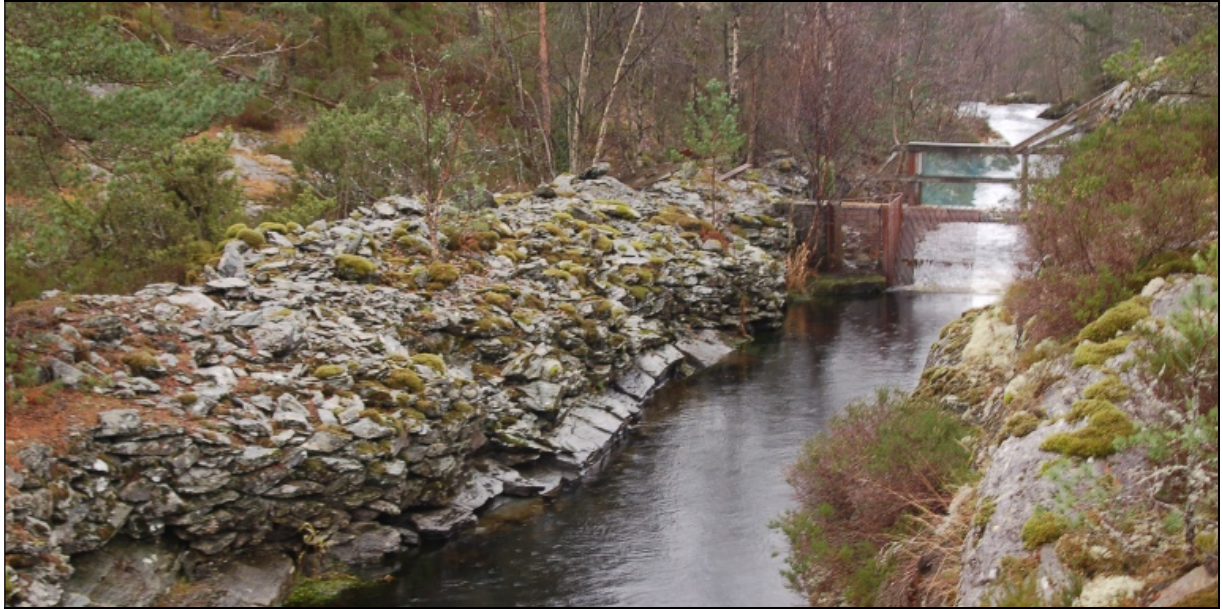
Figur 2. Utløpet fra Kvitebergsvatnet er kanalisert og senket tidligere, sannsynligvis for å hindre flomoppstiving for landbruksarealene i indre deler av innsjøen. Dette arbeidet er av eldre dato.
