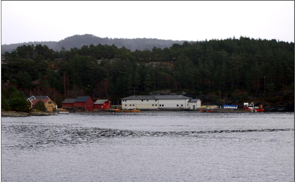
Figur 14. Det gamle settefiskanlegget sett fra sjøen.
