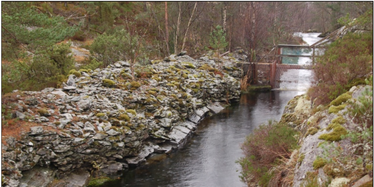
Figur 2. Utløpet fra Kvitebergsvatnet er kanalisert og senket tidligere, sannsynligvis for å hindre flomoppstiving for landbruksarealene i indre deler av innsjøen. Dette arbeidet er av eldre dato.
