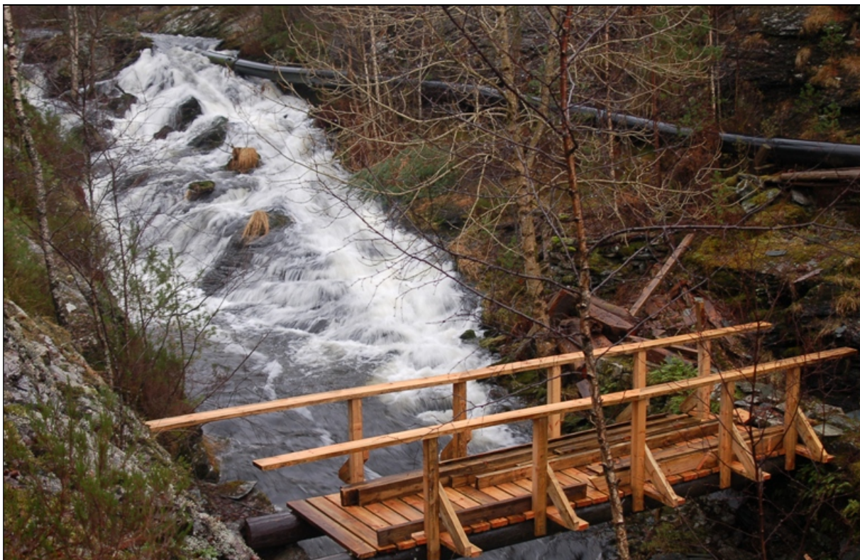
Figur 4. Tilførselsledningen til anlegget ligger delvis i kanten av elven og fra midtveis følger den langs østsiden nedover til anlegget (nederst).
