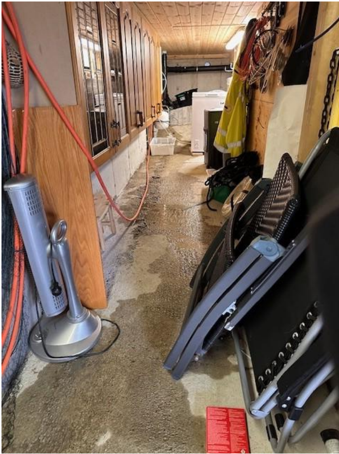
Bilde 5. inne kjellerrom svalgang 1
