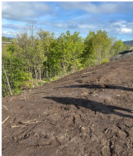
Fylling med toppdekke jord mot gbnr. 143/3
