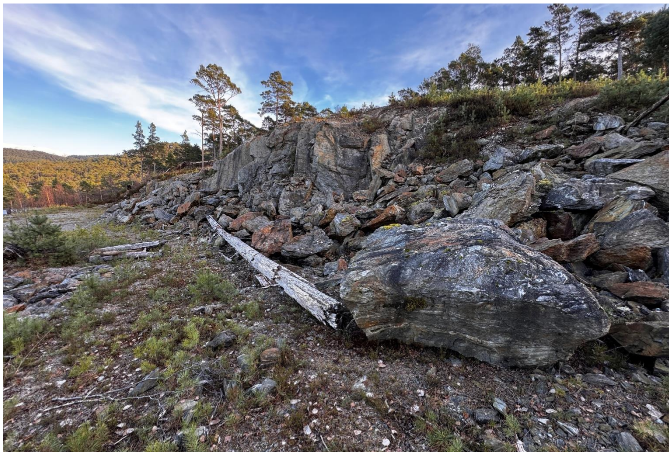
Figur 24 Infopunkt 3. Bergblotning øst i kartleggingsområdet har begrenset høyde på om lag 2 meter, og fremstår uten fare for utløsning av steinsprang som kan utgjøre en dimensjonerende fare i kartleggingsområdet. Bilde av Skrið as.
