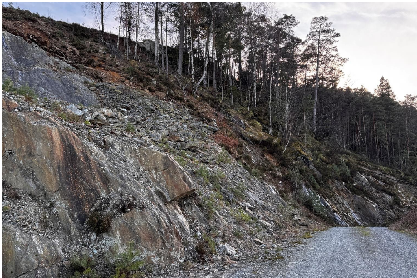
Figur 25 Infopunkt 4. Langs tilkomstveien vest i kartleggingsområdet er det bratte areal av oppsprukket berg og mindre overheng, med helning over 45°. Bilde av Skrið as.
