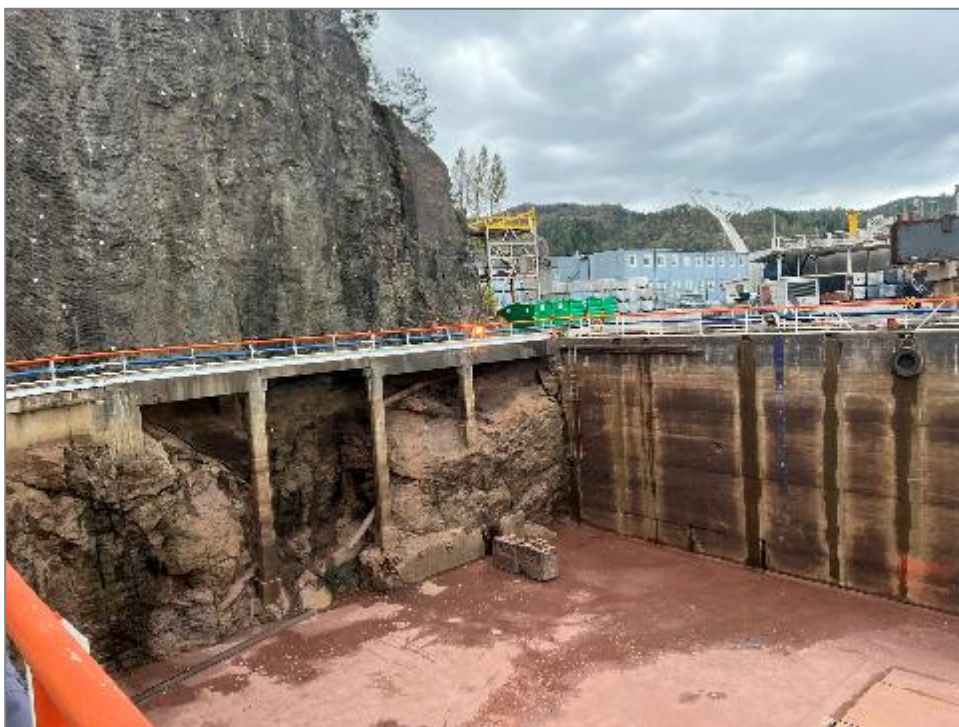
Figur 25: Tilkomstveg/bru i bakkant av eksisterande dokk.
