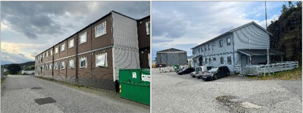
Figur 8: T.v.: Eksisterende brakkerigg som ligg på sørsida av Røysanesvegen. T.h.: Eksisterende administrasjonsbygning.
