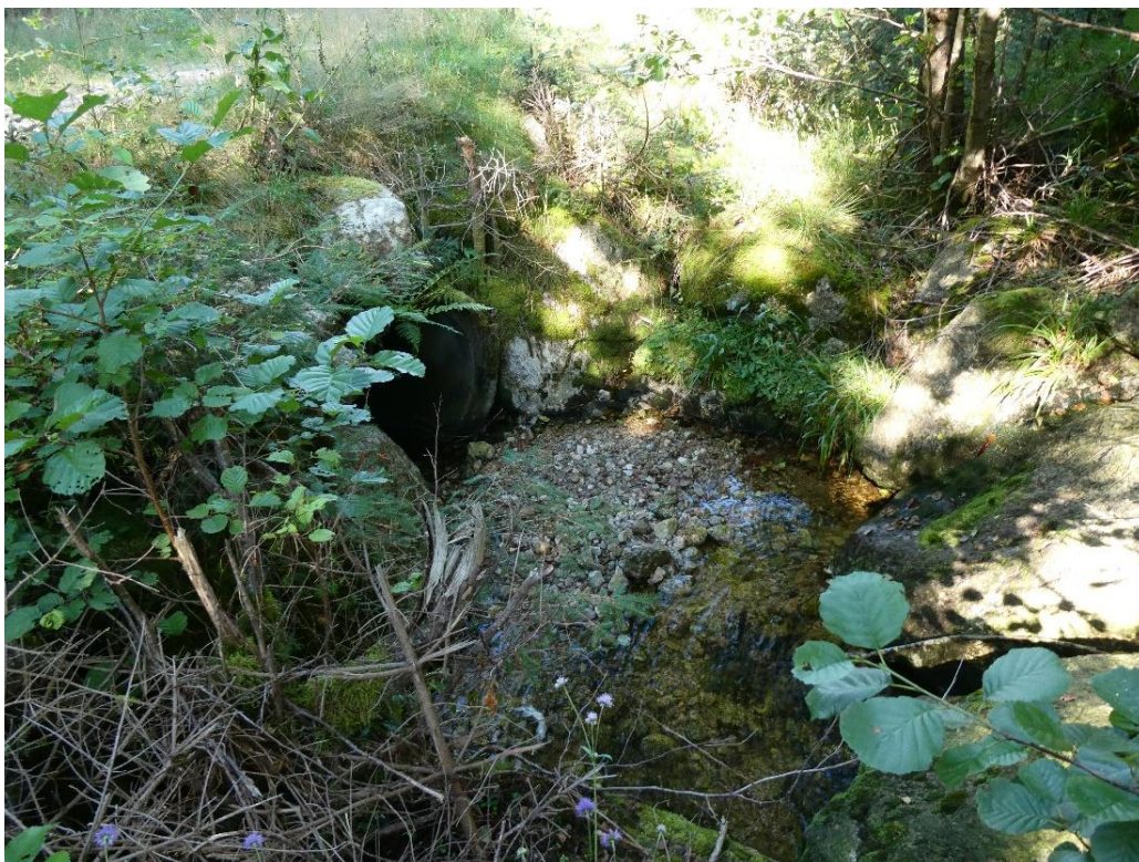
Figur 12. Masseavlagring i inntak til stikkrenner i terrenget ovanfor planområdet i aust.
