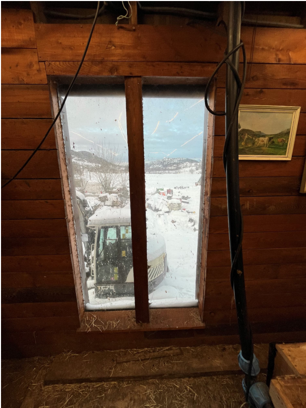
Figur 30 Nytt vindu i fasade mot vest
