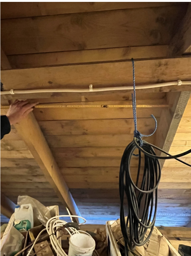
Figur 29 Nye taksperrer og sutak av plank
