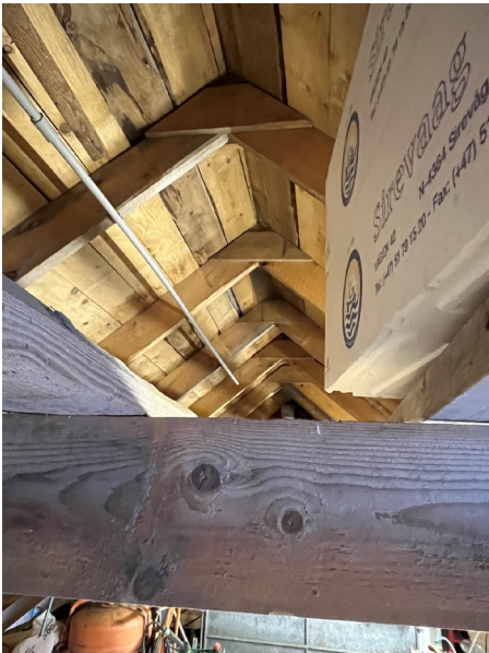
Figur 14 Foto viser nye taksperrer, sutak og hanebjelke
