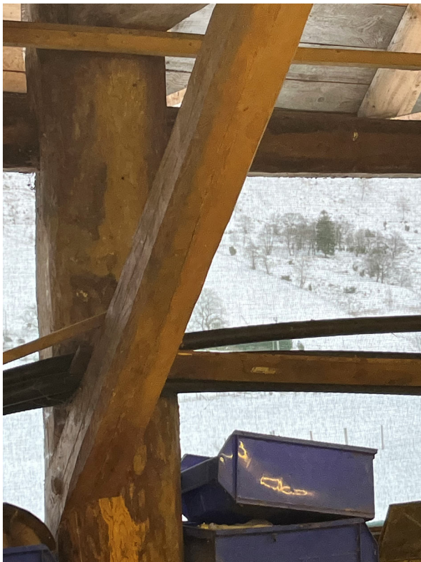
Figur 26 Del av eksisterende grindverk
