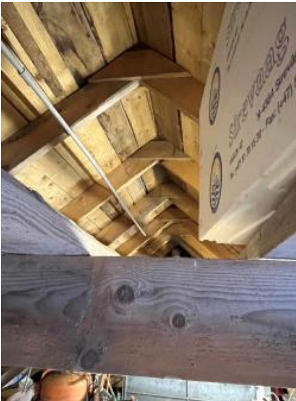
Figur 6: Foto viser nye taksperrer, sutak og hanebjelke.
