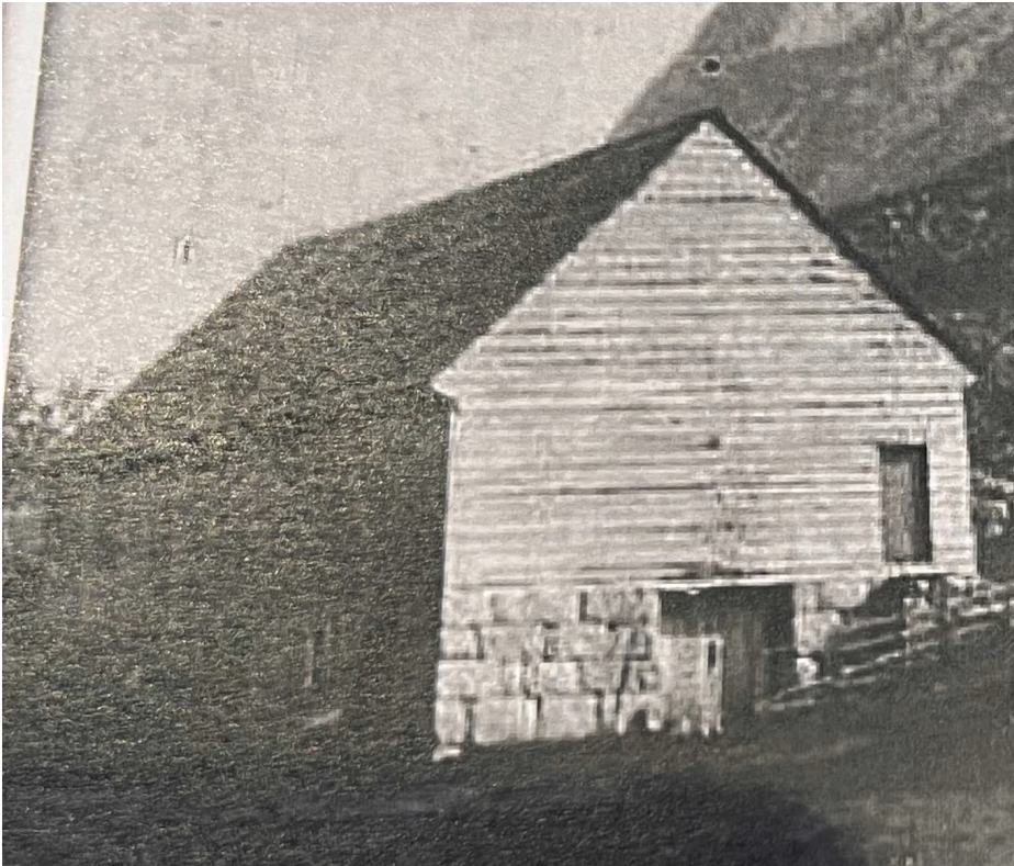
Figur 41 Foto av opprinnelig låvebygg, av ukjent dato. Foto viser fasader mot vest og nordøst
