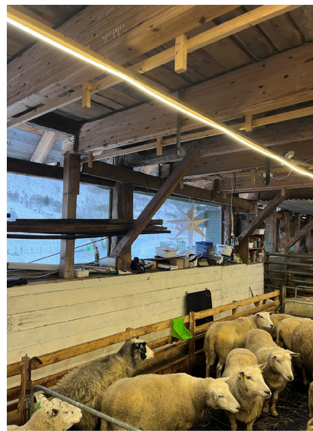
Figur 11 Foto viser limtrebjelker og søyler i fasade mot nordvest
