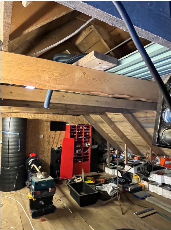
Figur 28 Nytt gulv i plan 3, nye taksperrer og hanebjelker
