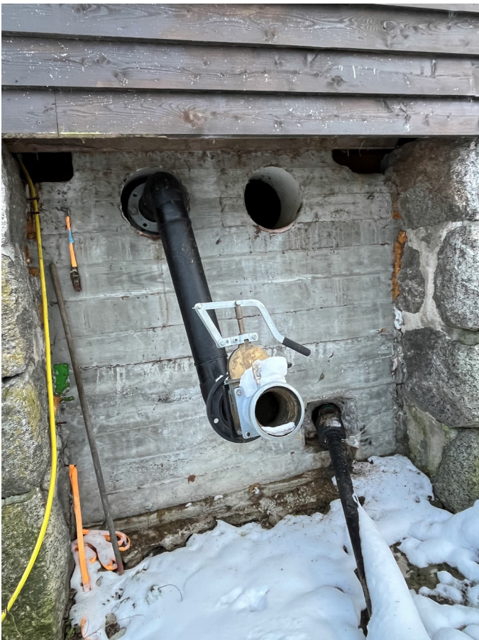
Figur 33 Gjenstøpt åpning i fasade mot vest
