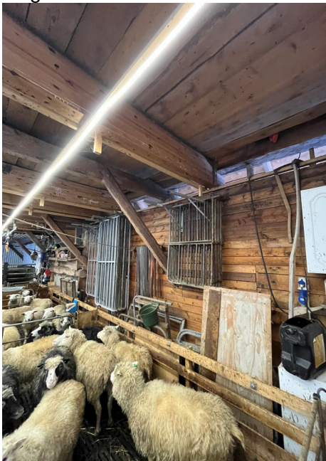
Figur 12 Foto viser nytt låvegulv sett fra undersiden/plan 2
