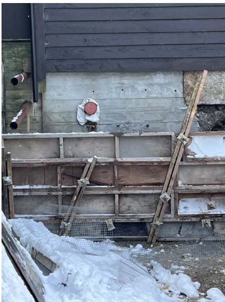
Figur 16 Gjenomgående betongvegg i overgang mellom eksisterende og nytt tilbygg
