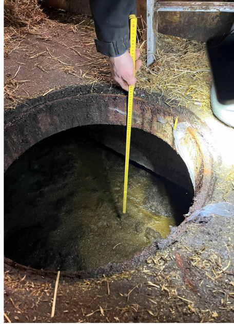
Figur 23 Foto viser høyde fra ok dekke til underkant bjelke
