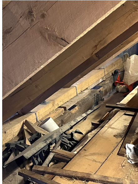
Figur 15 Foto viser opplegg for nye taksperrer
