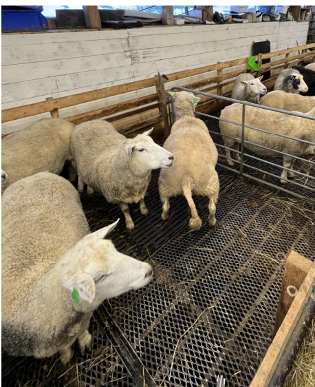
Figur 20 Foto viser gulv av strekkmetall
