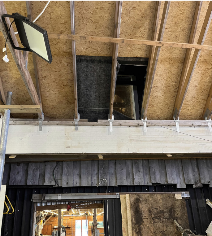
Figur 32 Fra nytt tilbygg, luke i tak til plan 3 eksisterende bygg
