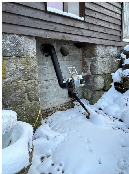
Figur 17 Foto viser gjenstøpt åpning i fasade mot vest
