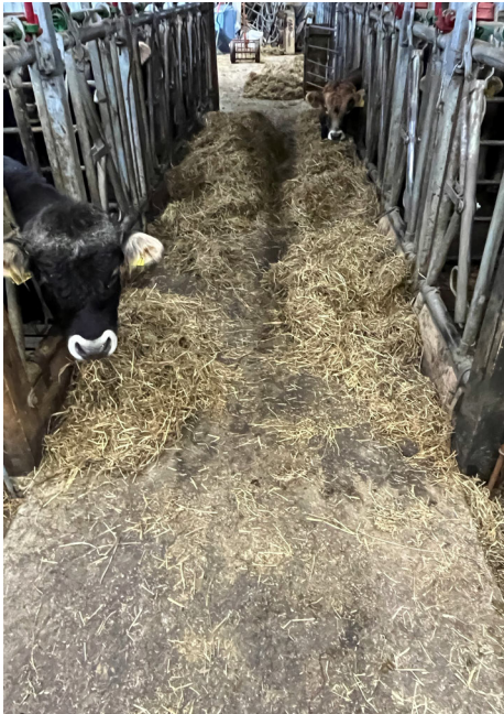
Figur 18 Foto viser nytt forbrett av betong
