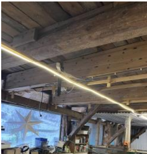
Figur 7: Foto viser nye limtrebjelker og søyler.
