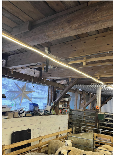
Figur 9 Foto viser to limtrebjelker med søyler, plassert mellom to grinder
