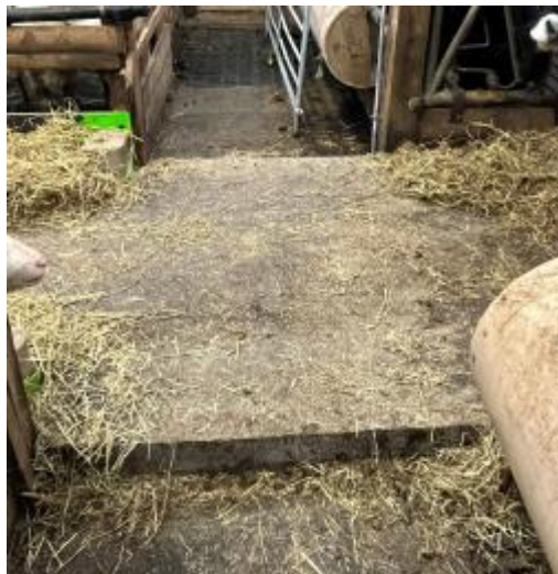
Figur 8: Nytt forbrett av plastøst betong.
