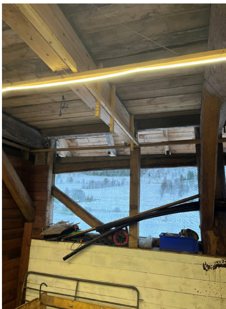
Figur 10 Foto viser limtrebjelke og søyle i fasade mot nordvest
