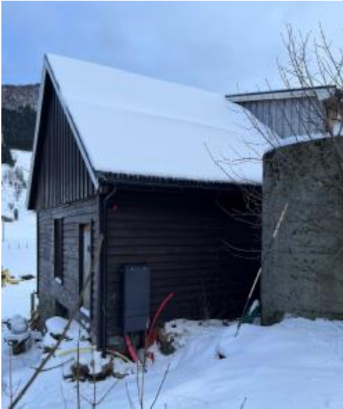
Figur 9: Fasade mot vest som viser nytt vindu
