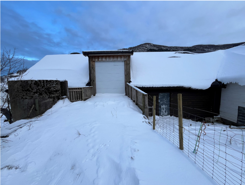
Figur 34 Ny port ved låvebru
