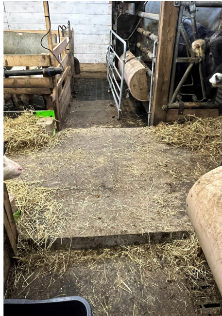
Figur 19 Foto viser nytt forbrett av betong
