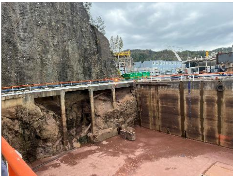
Figur 25: Tilkomstveg/bru i bakkant av eksisterande dokk.
