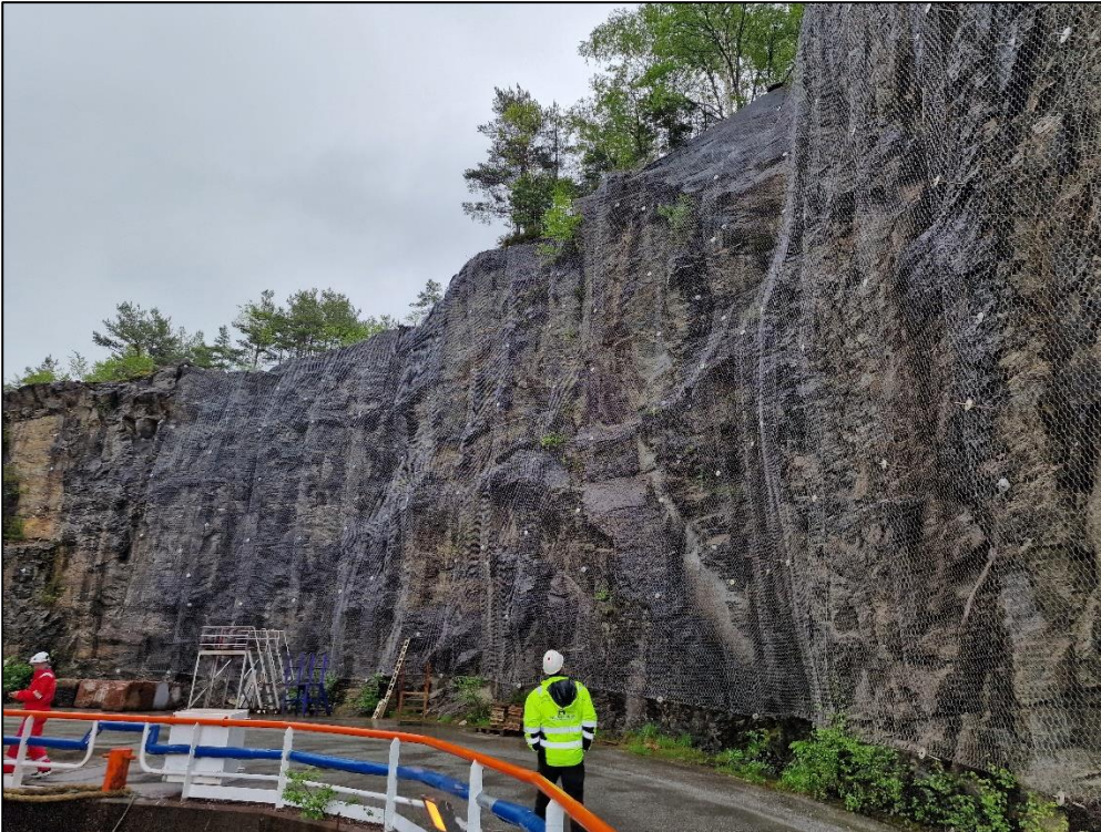
Foto 3: Bergskjæringer langs kortsiden og langsiden av eksisterende dokk. Foto mot NØ.
