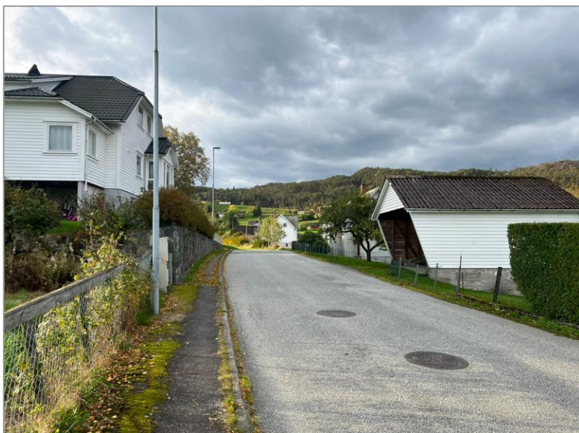
Figur 81: Eksisterande garasje og mur langs Slettanesvegen ved gbnr. 202/28-39,73).
