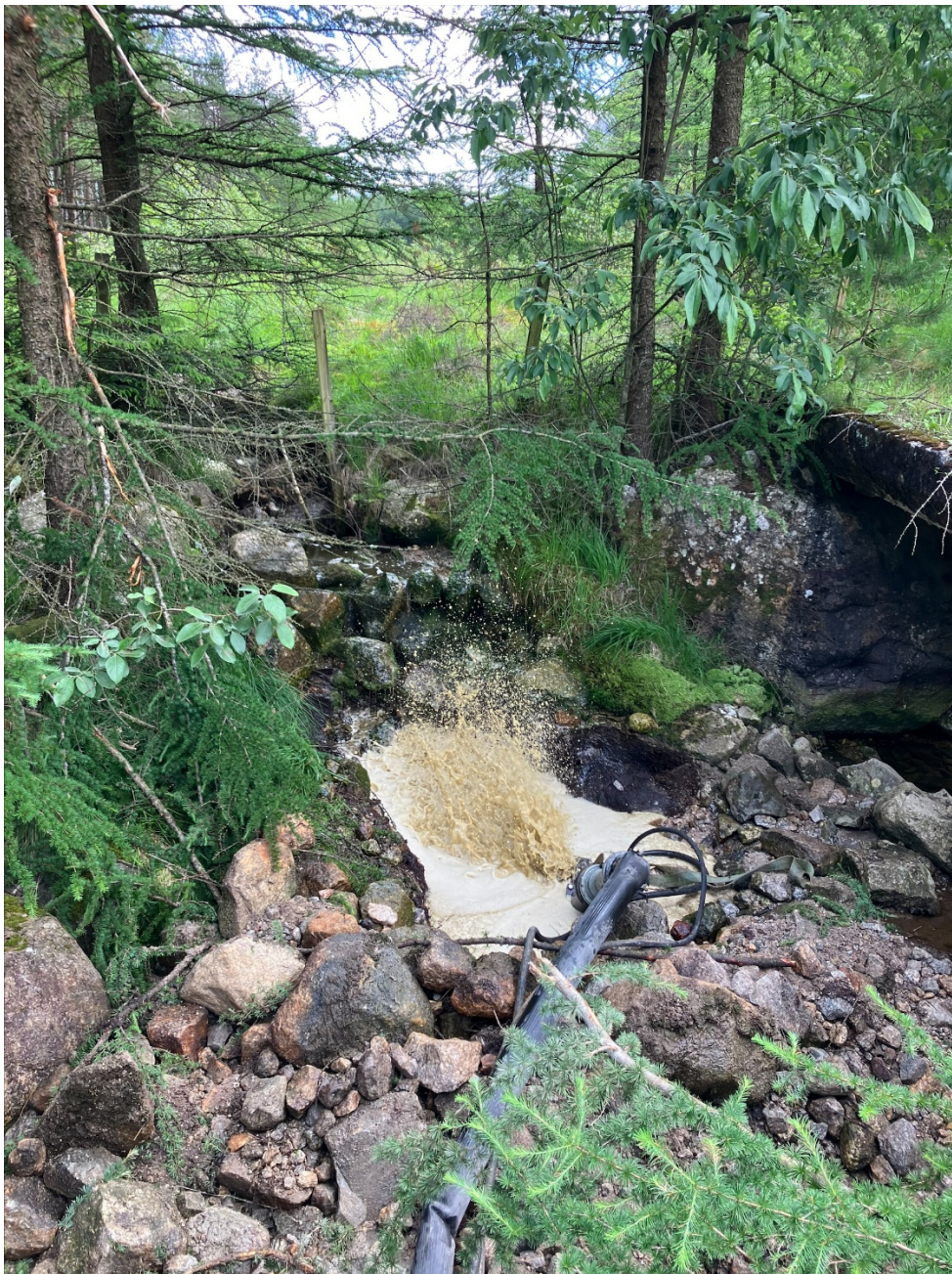
Fangdam med pumpe som saug opp forureina vatn.
