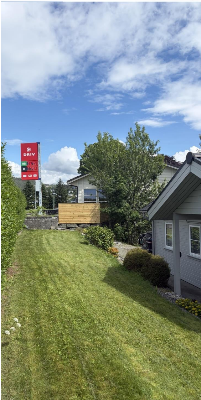
Figur 1 Manglende skjerming mot nabo, levegg for lav.
