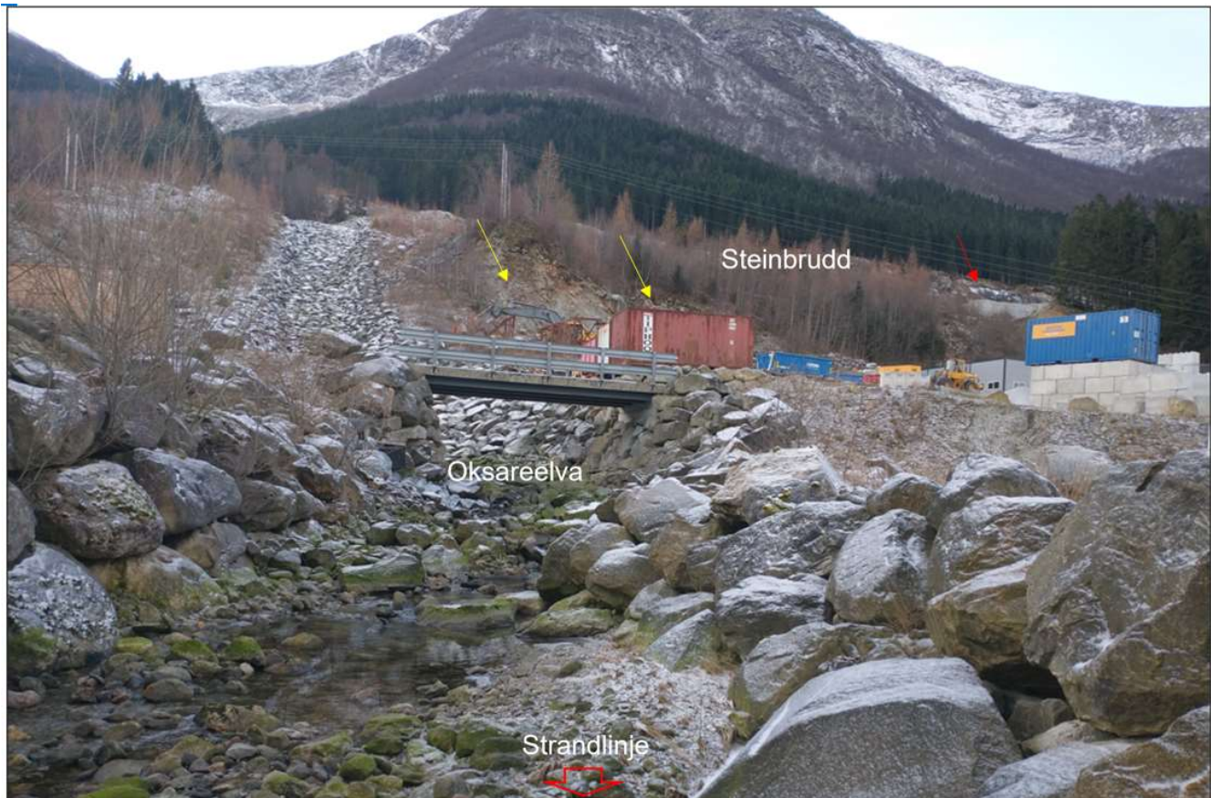
Figur 26 Oversikt av område utforming og stabilitet lokalt ved vurdert areal. Arealet avgrenses i øst av Oksareelva. Elven fremstår meget stabil og godt sikret. Videre observeres det, like i bakkant av bygninger og lagerplass bratte skrånninger med løsmasser med pågående erosjon og utrasing (gule piler). Ovenfor skrånningene skimtes steinbruddet med kun tynt løsmassedekke over fast fjell (rød pil).
