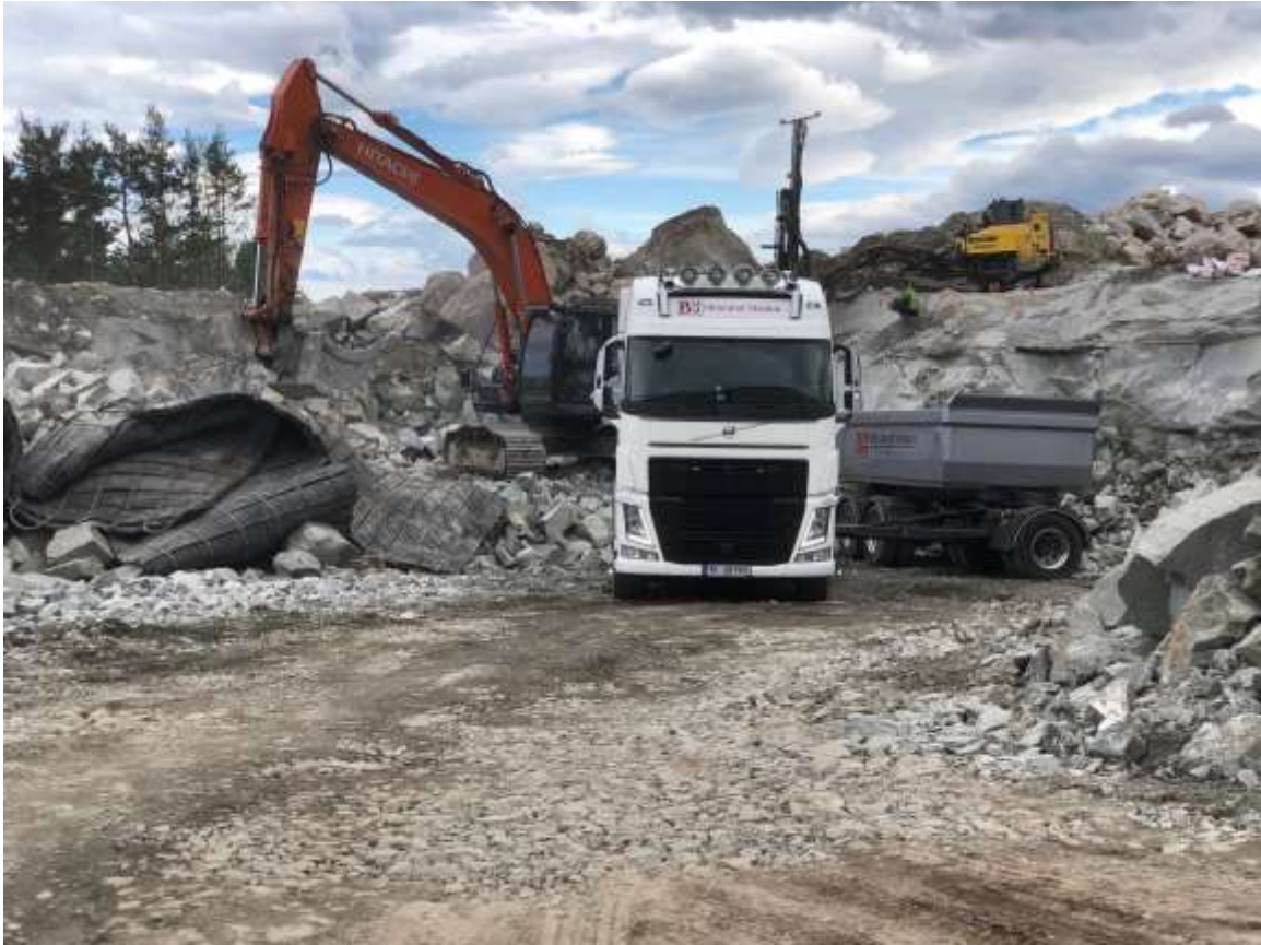
Opplasting av sprengstein på lastebil
