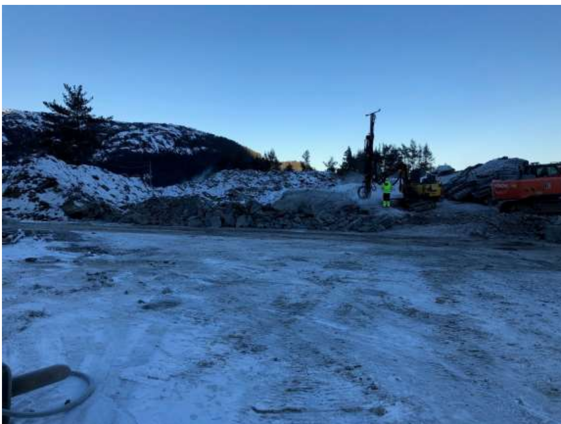
Bilde tatt under boring av fjell.
