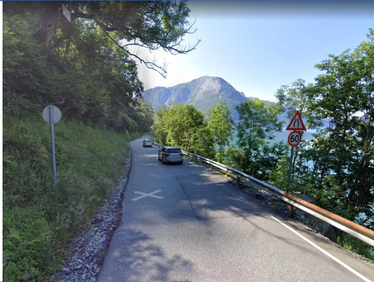
Smalare veg frå Nordrepollen-tunnelen i retning Austrepollen.
