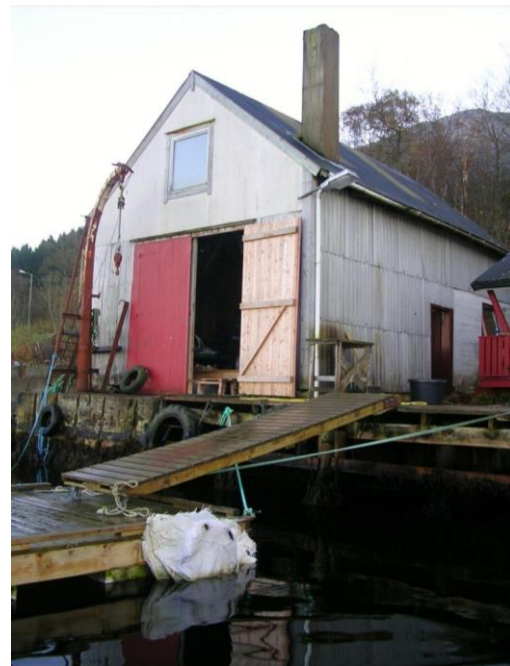
FIG. 02 NAUST FØR BRANN SETT FRA SJØ.
