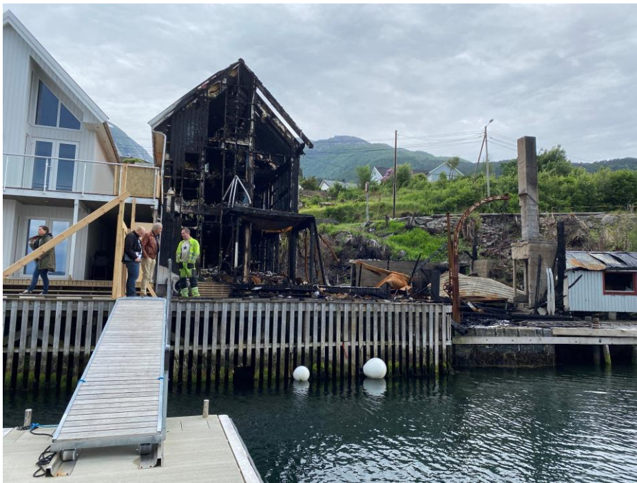
Fig.06 EIKELANDET BRYGGE, NEDBRENT BYGNING. RESTER AV NAUST MED PIPE, ANNEKS
