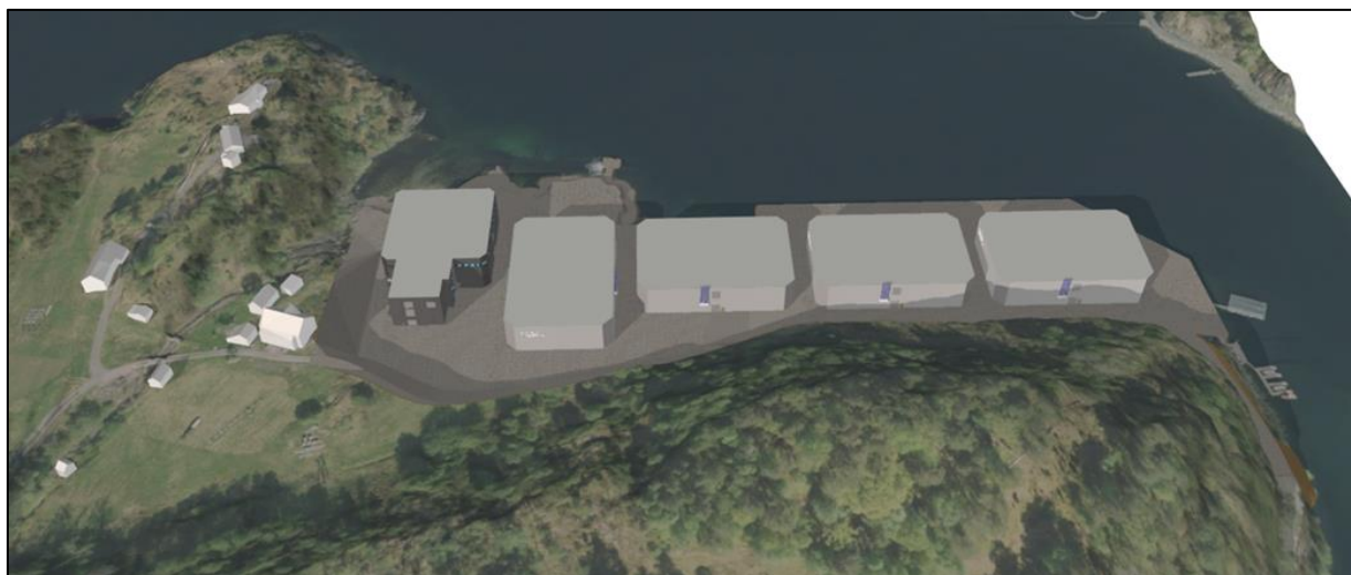
Figur 1. Oversikt over anlegget slik det vil kunne framstå etter utvidelsen. Hele dagens anlegg skal erstattes med et nytt RAS anlegg, som blir liggende delvis på fylling i sjø.
