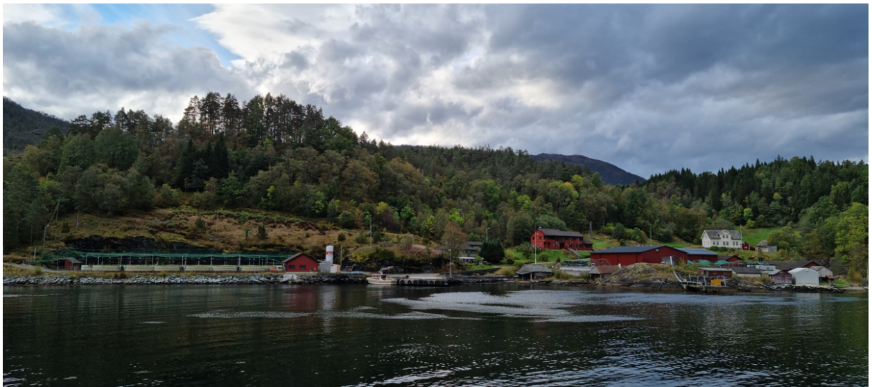
Figur 5 - Foto som syner eksisterande settfiskanlegg med tilhøyrande bygningar, Foto: Omega 365 Areal
