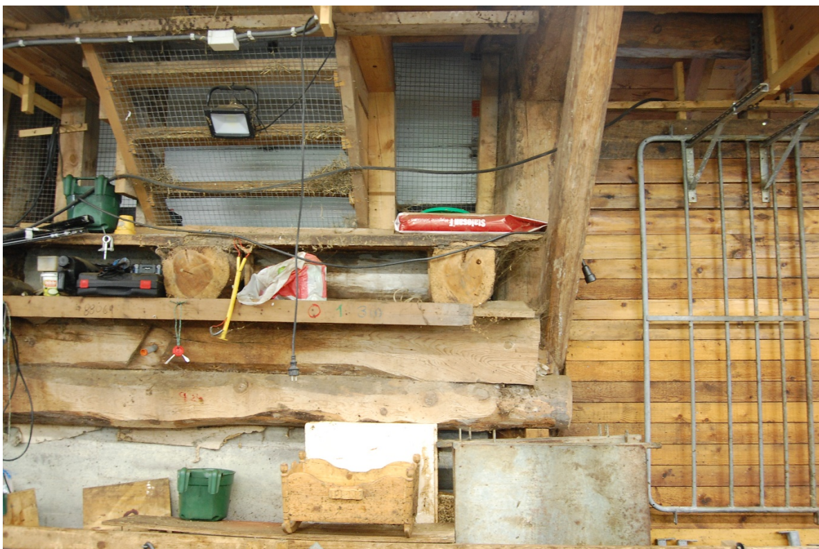
Foto: Enkel trapp opp til høyløft, bjelkar og konstruksjon frå det eldre bygget er synlege. Dei avkappa endane som er synlege er det som står att frå den innvendige låvebrua og fjerning av innvendig låvebru påverkar ikkje bygget si bæreevne.
