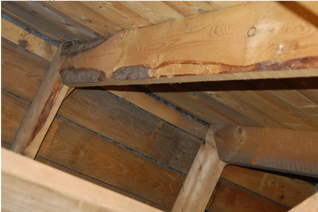
Bilete frå synfaring 04.07.24 av takkonstruksjon/sperretak.
