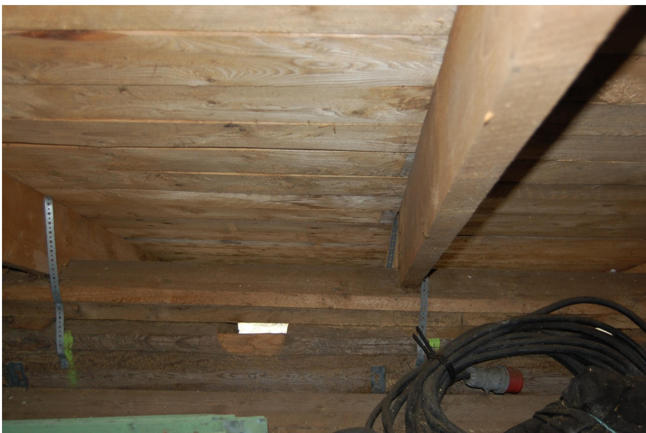
Foto: Innfesting av takkonstruksjon på grindverksbygget.
