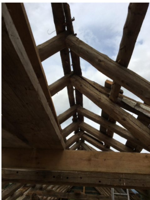
Gamle takkonstruksjonen. Vanleg sperretak, utan mønedragar.
