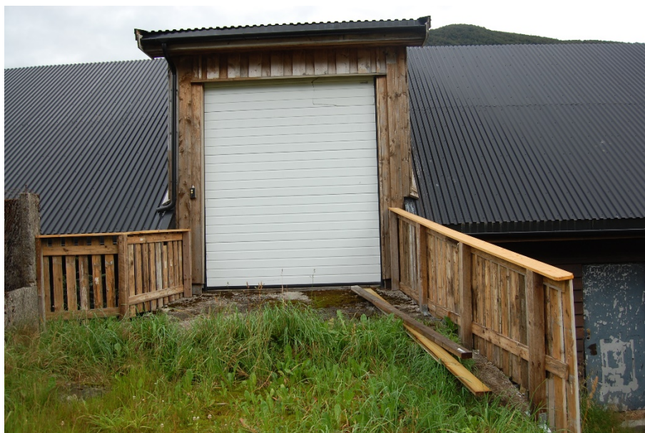
Foto: Ny automatisk port til låvebrua og nytt ståltak.
