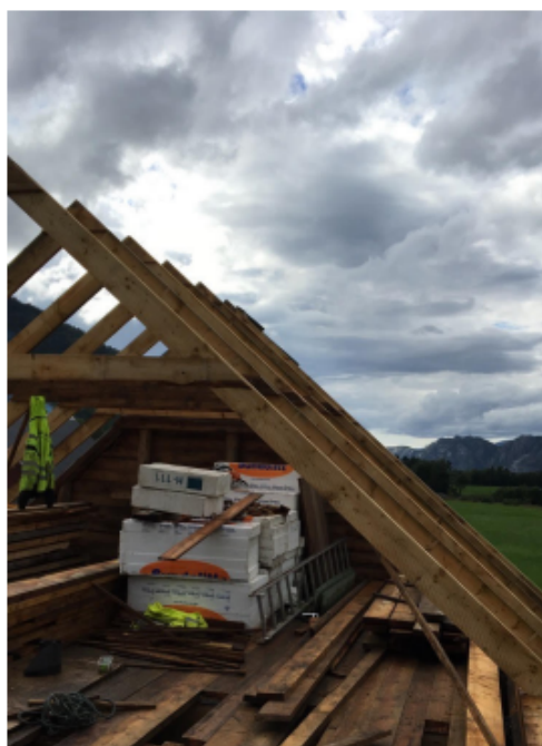
Bilete av nytt sperretak utan mønedragar. Begge foto sendt inn frå tiltakshavar i sak 2023/1747 JP 41.
