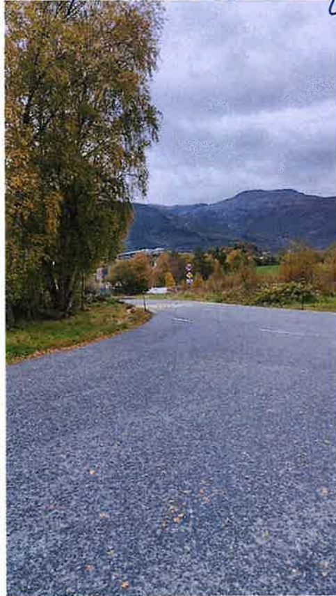
Siktlinj e etter fjerning av tre
