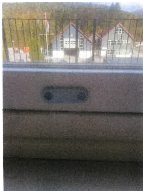
Blendet vindu mot svalgang
