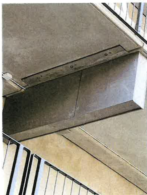
Montert røykskjørt
