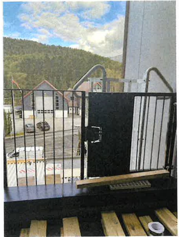
Trapp for rømming frå 4. til 3. etasje Ny lås er montert. Se bilde s 9 KE. (Vigor)
