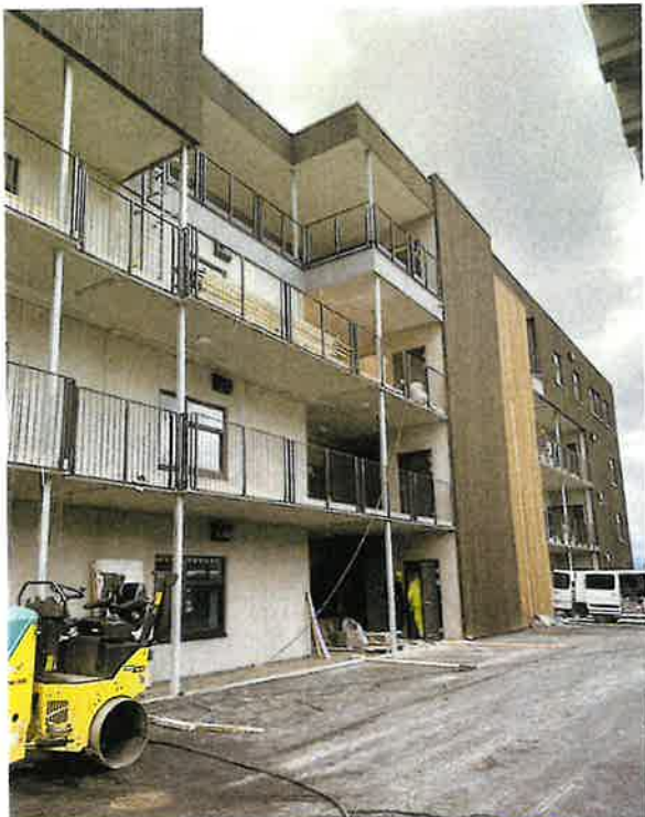
Fasade mot nord, viser heisområdet Ok. 30.09.24 KE
