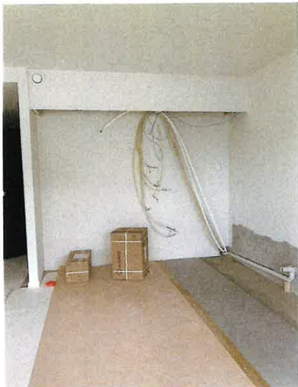
Kjøkken under arbeid
