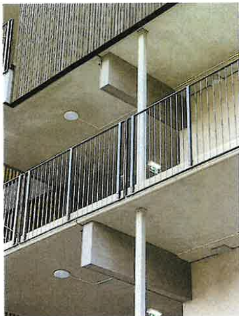
Monterte røykskjørt
