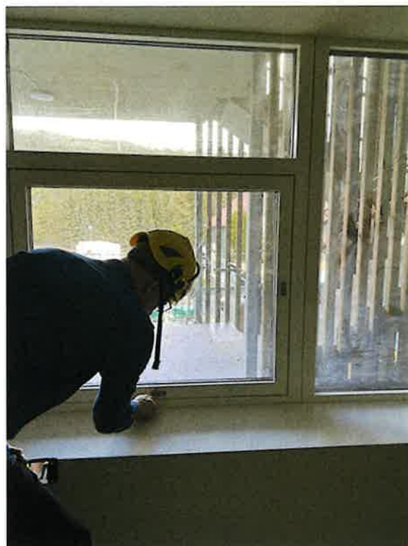
Vindu mot svalgang
