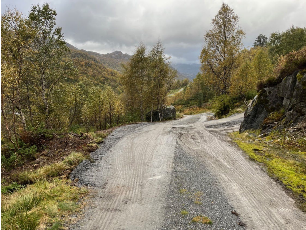
Foto 4: September 2023 etter utvidelse av kryss
