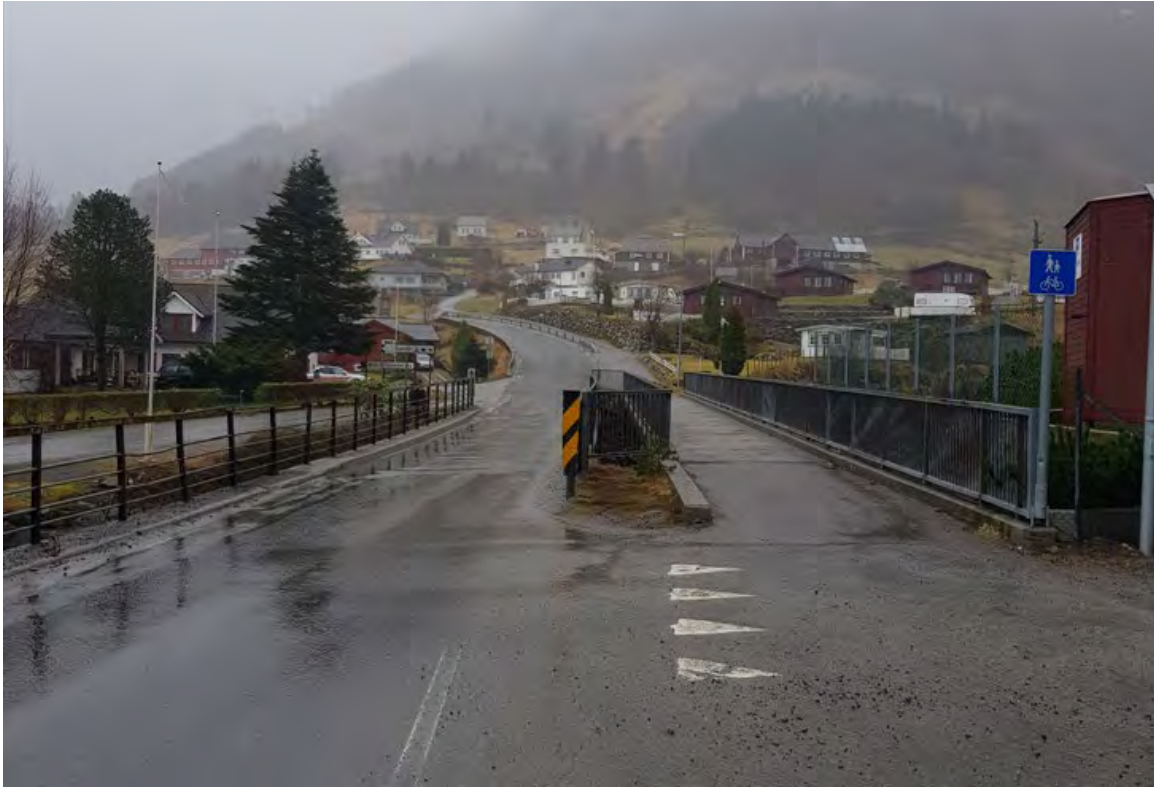
Figur 23 Sunndalsvegen og bru. Foto frå synfaring.
