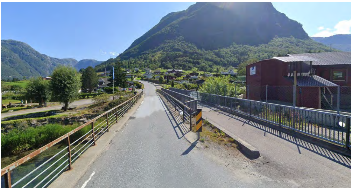
Figur 31: Starten på gangveg på sørsida av vegen. Denne førar heilt til starten av Bondhusvegen. Foto: Google maps
