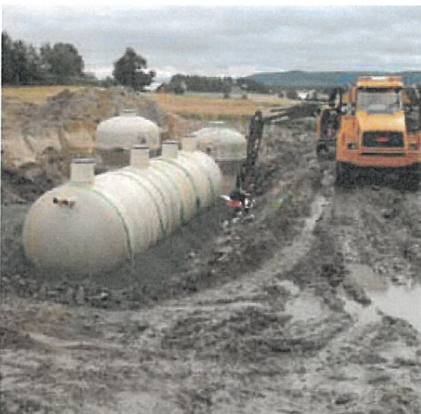
Slamavskiller med infiltrasjon under bygging.
