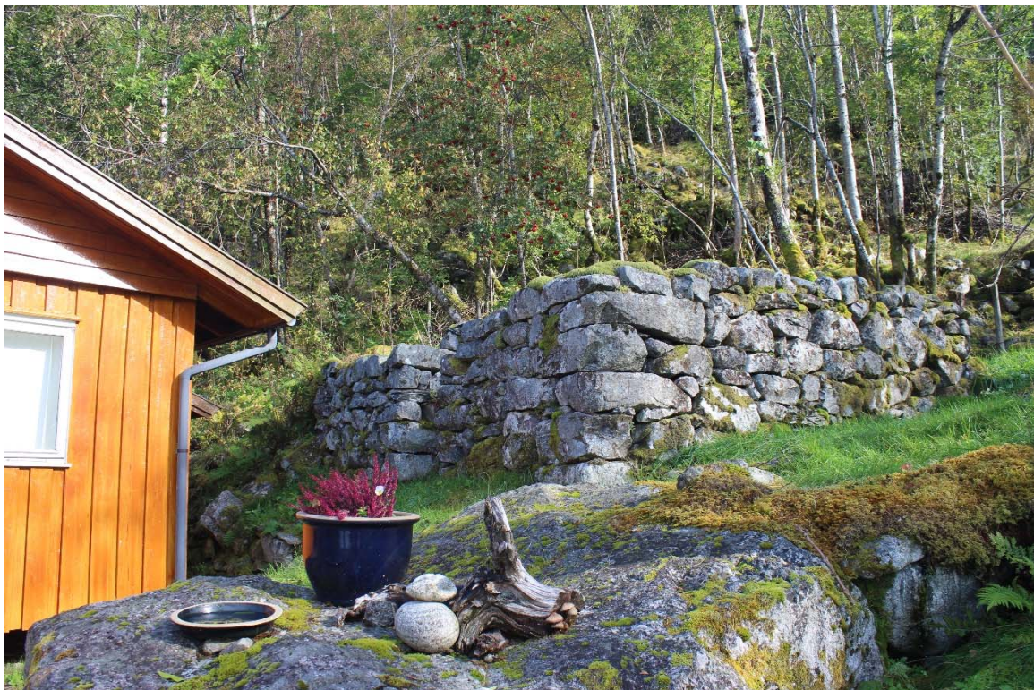
Figur 23 Gamal grunnmur på husmannsplassen Træet på Kroka, som ligg ved fv 500 like utanfor planområdet. Foto Tine Eikehaug, Statens vegvesen
